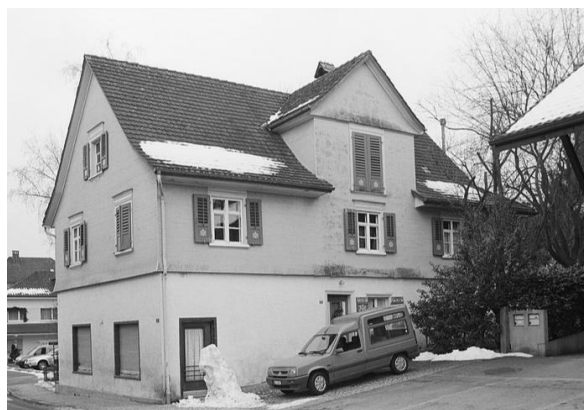
Abb. 8: Kulturobjekt KO24, Scherzingerstr. 3, Westseite
